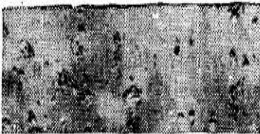
Рисунок 2 – Пример образования питтинговой (точечной) коррозии внутренней поверхности трубы из алюминиевого сплава при эксплуатации в морской воде
