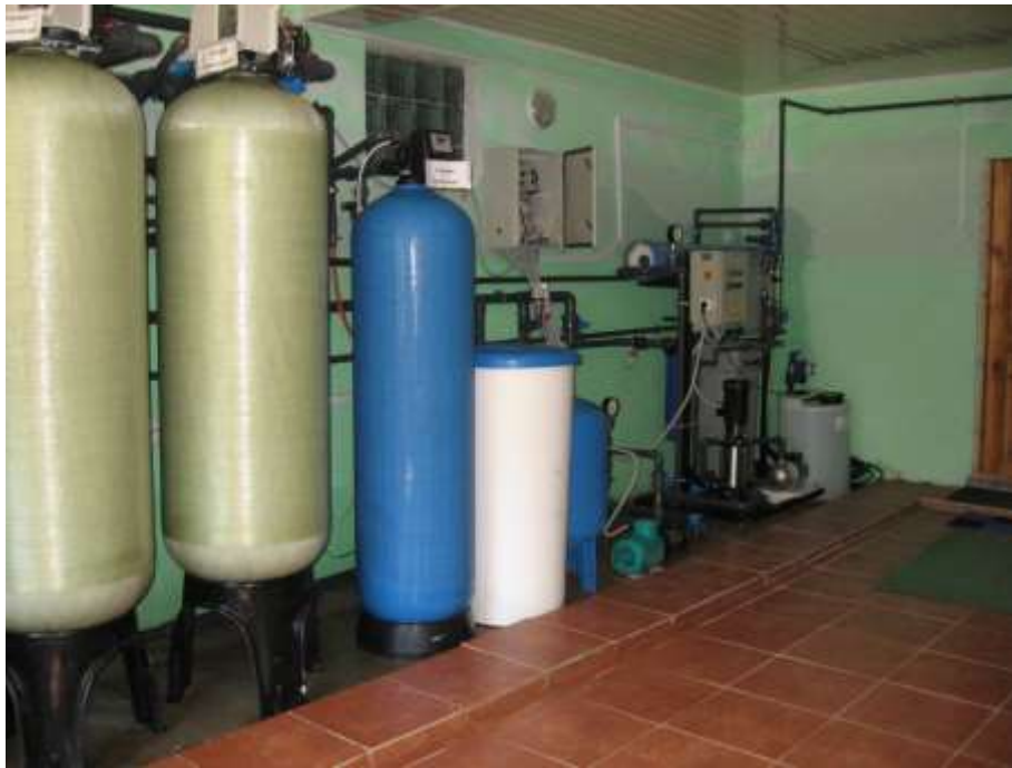
Рисунок 1 – Узел первичной водоподготовки [2]
